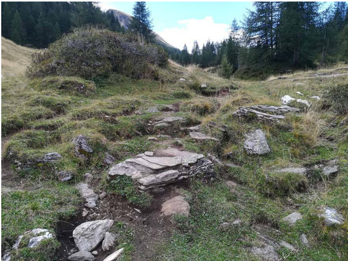
Foto 22: Intervento 21. Allargamento e regolarizzazione del fondo e demolizione di alcune porzioni rocciose
