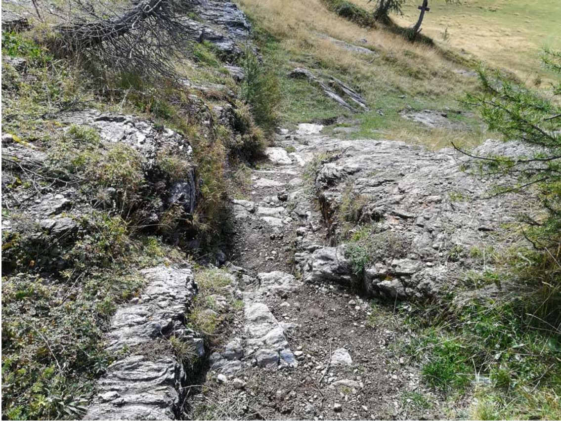
Foto 40: Intervento PT11. Trincea in roccia da riempire a formare una rampa in pietrame più regolare
