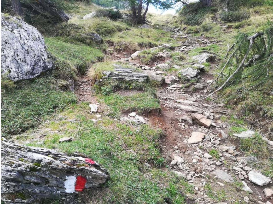
Foto 23: Intervento 22. Allargamento e regolarizzazione del fondo e demolizione di alcune porzioni rocciose
