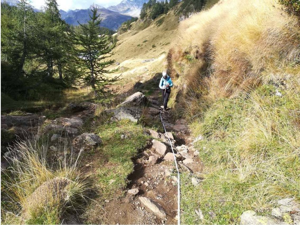
Foto 42: Intervento PT12. Tratta rocciosa da superare tramite una rampa in pietrame
