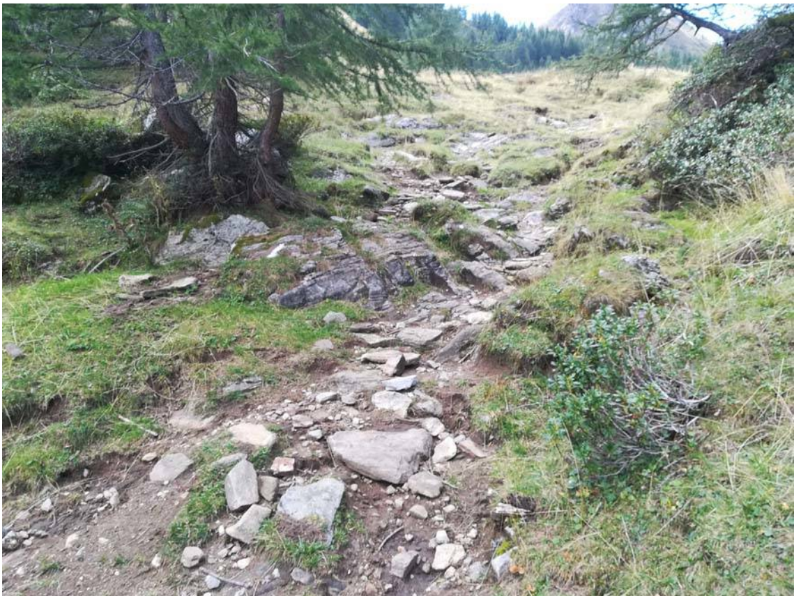
Foto 24: Intervento 22. Allargamento e regolarizzazione del fondo e demolizione di alcune porzioni rocciose
