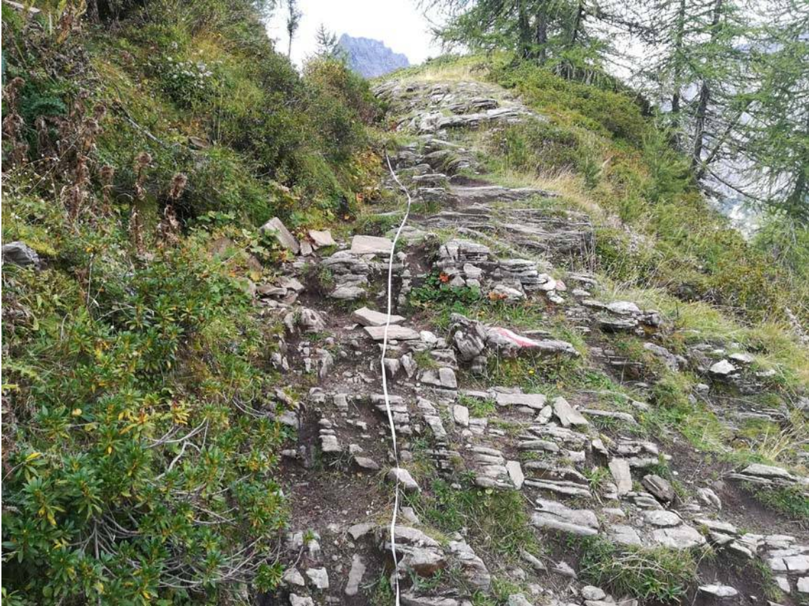
Foto 15a: Intervento 15. Sentiero ripido in roccia da regolarizzare
