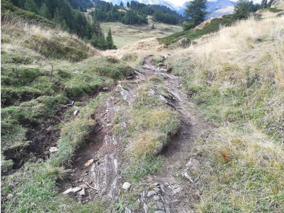
Foto 25: Intervento 23. Demolizione di alcune porzioni rocciose
