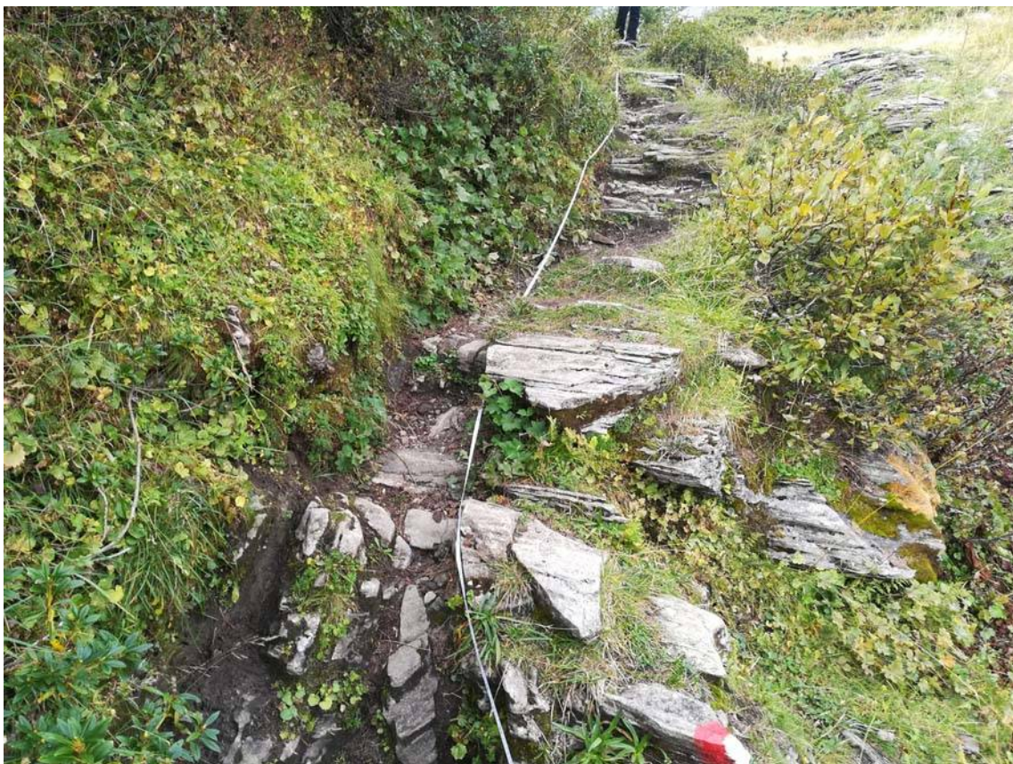
Foto 15b: Intervento 15. Sentiero ripido in roccia da regolarizzare
