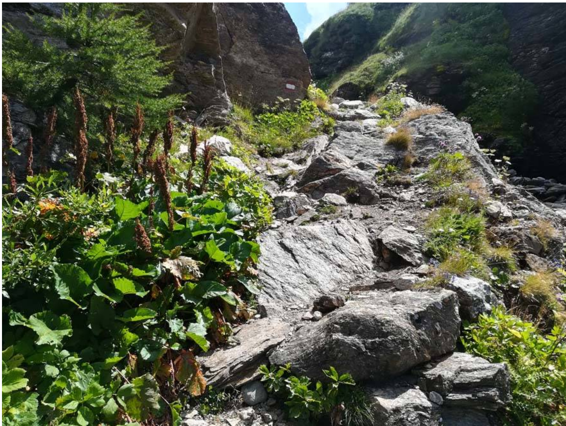
Foto 6b: intervento lineare 6: tratto particolarmente dissestato lungo il Rio della Valle
