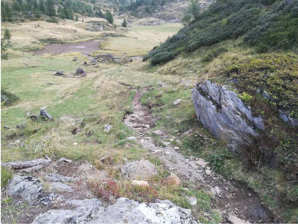
Foto 20: Intervento 20. Allargamento e regolarizzazione del fondo
