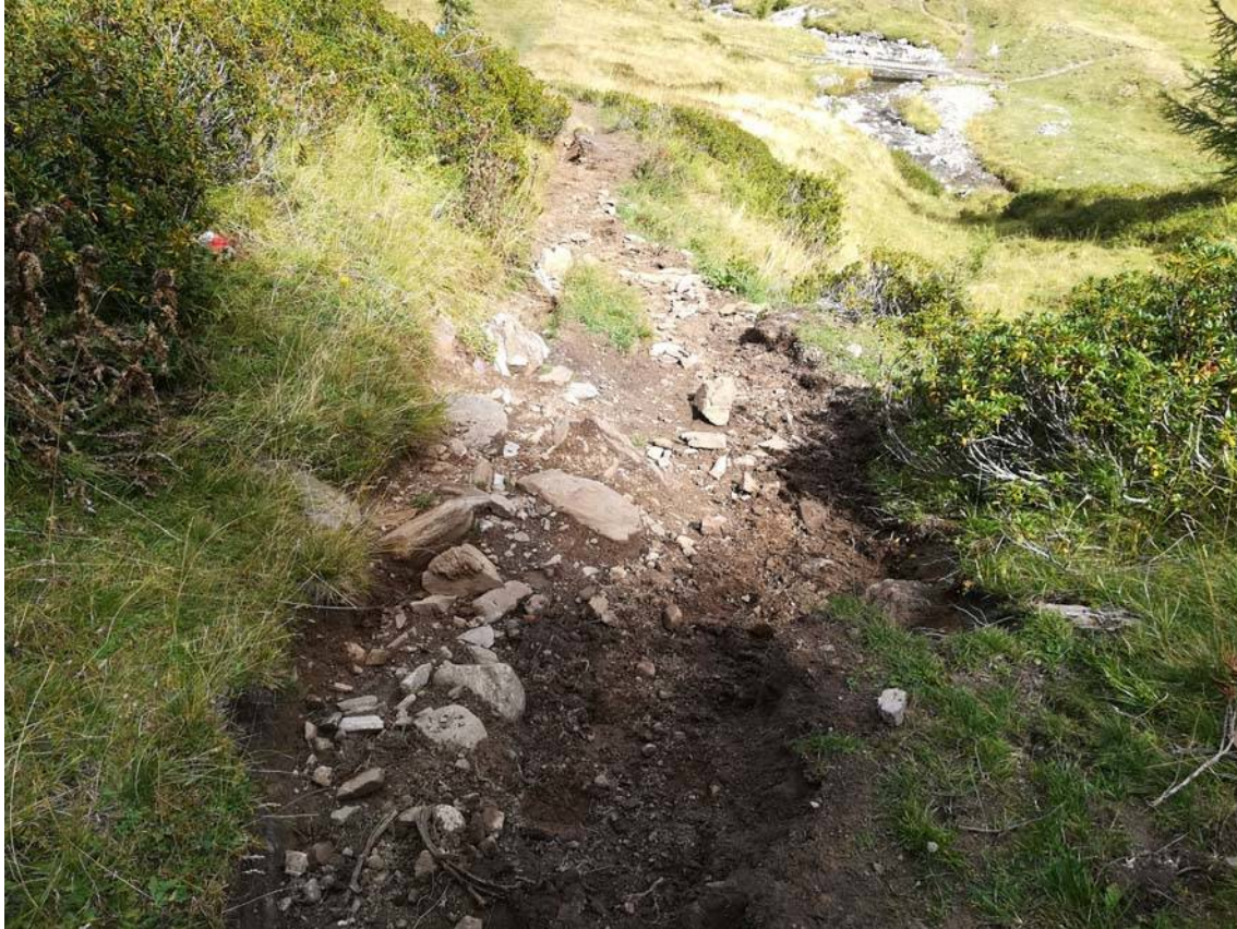
Foto 14: Intervento 14. Sentiero ripido molto rovinato che deve essere effettuato in salita. L'obiettivo è rendere il fondo più regolare e scorrevole dove la bici possa essere accompagnata di fianco senza doverla portare in spalla
